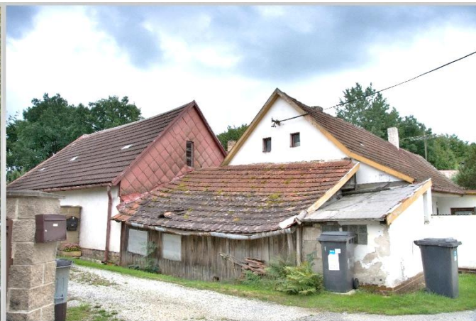
Pohled z mostu ve Stránské ulici na čp. 169.
