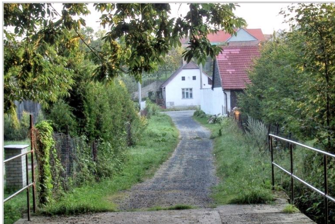
Pohled do Podfarské ulice od ČOV.
