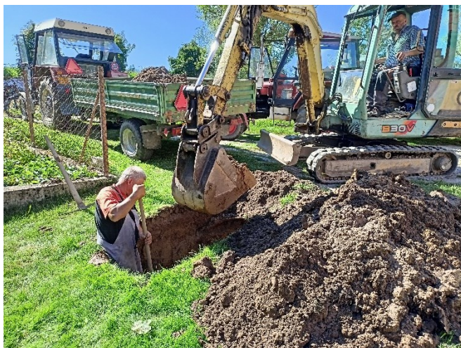
Oprava vodovodu na stráních.
