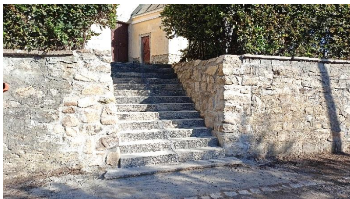
Schodiště od kostela k faře
