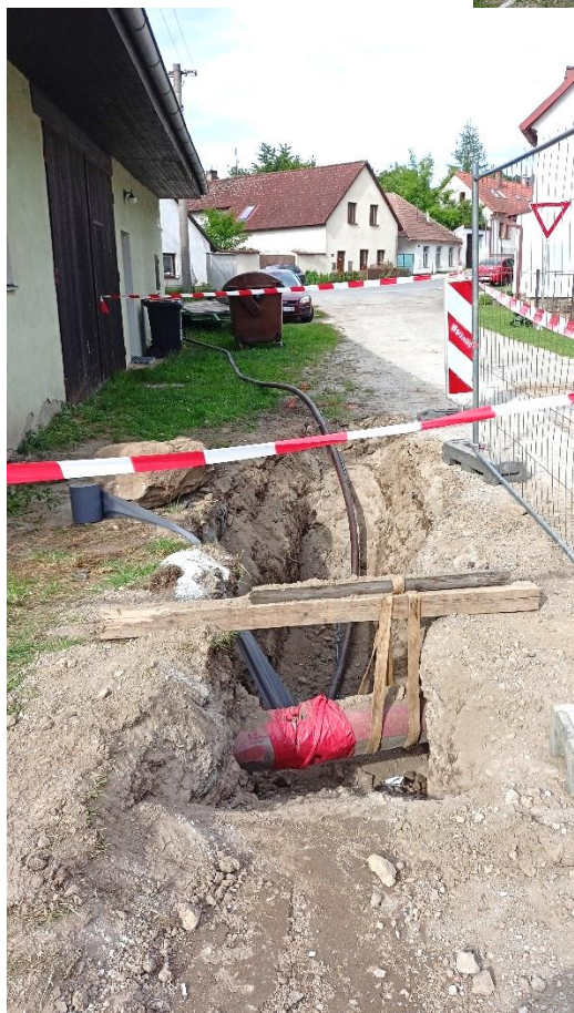
Kanalizace Na Zájezku.
