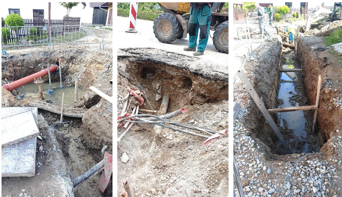
Výstavba vodovodu a kanalizace na Stráních.
