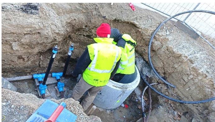
Kanalizace a vodovod
