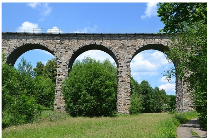
Kloužovice – železniční viadukt
