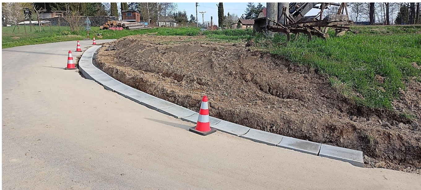
Podélný žlab v Podfarské ulici.
