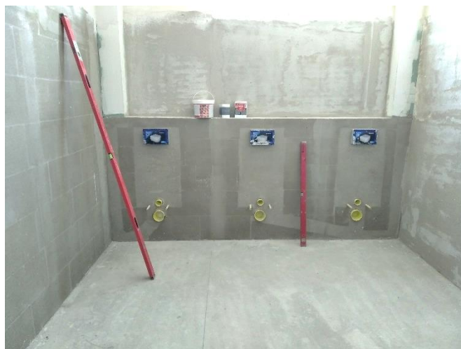
Modernizace ZŠ Deštná – WC 1. patro.
