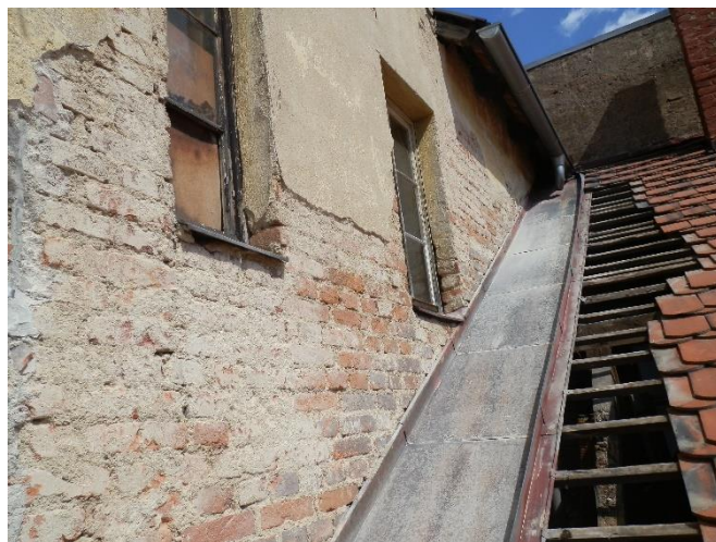
Výměna krytiny a latí na čp. 9 na náměstí.
