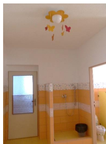
Oprava umývárny a WC ve školce, 1. patro.
