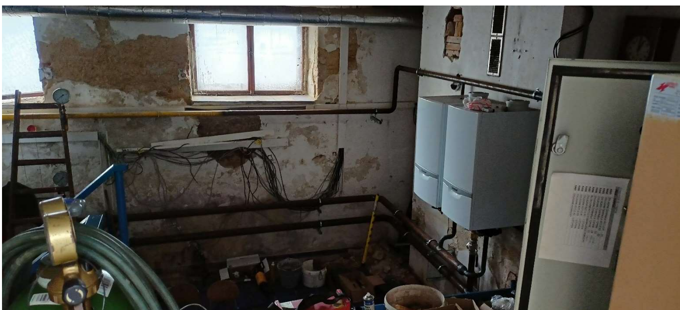
Opravovaná kotelna v základní škole.
