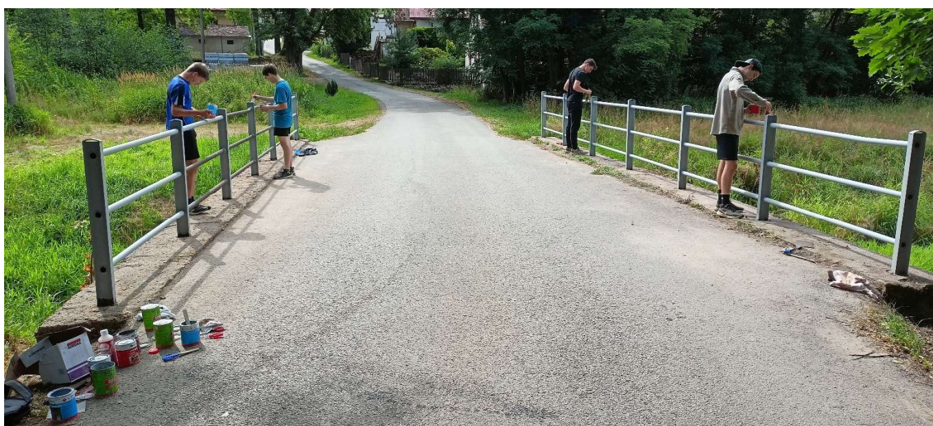
Práce na mostě Světecká ulice.
