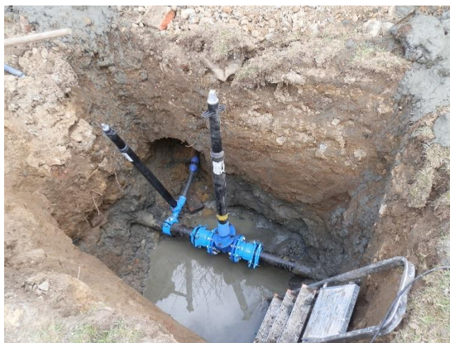
Výměna šoupěte v Podfarské ulici.
