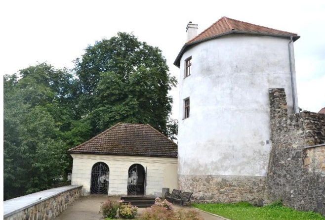
Bývalá bašta a Šachový altán
