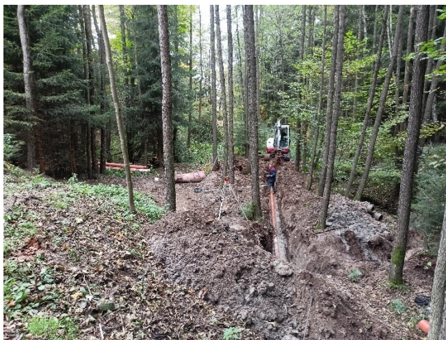
Odtokové potrubí na vodárně.
