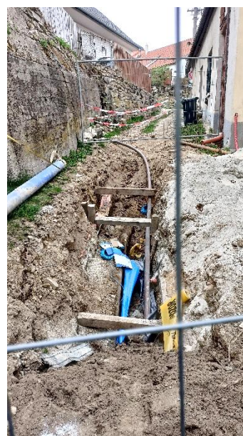
Tlaková kanalizace a vodovod
