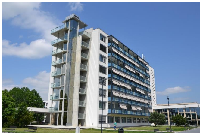
Lázně Aurora – budova s vyhlídkovou plošinou
