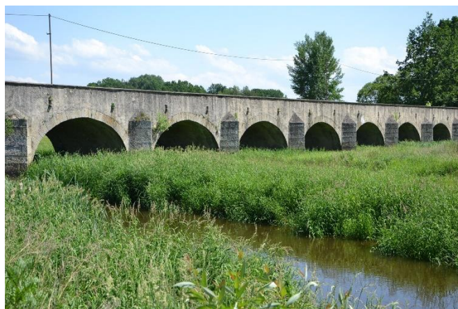
Stará Hlína – kamenný most přes Lužnici
