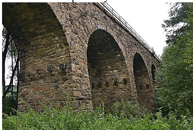
Pacov – železniční viadukt
