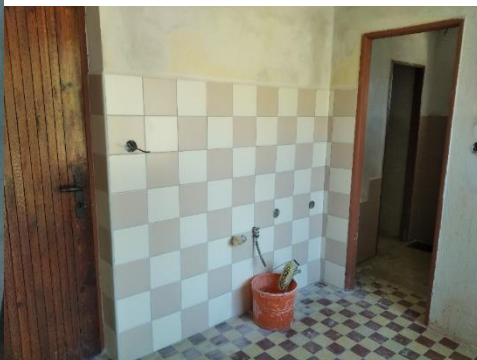
Oprava WC v KD Lipovka.
