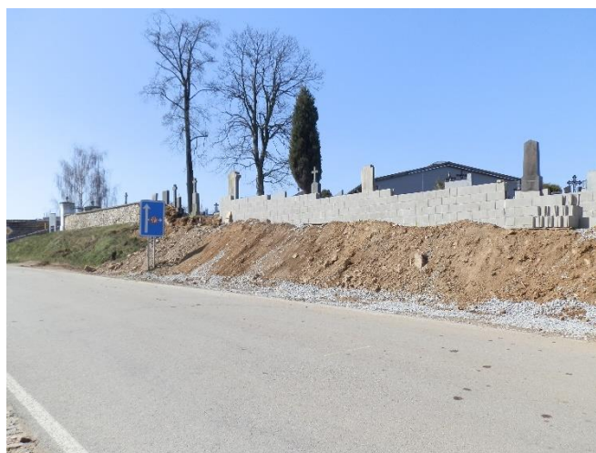
Opravy hřbitovní zdi začaly.
