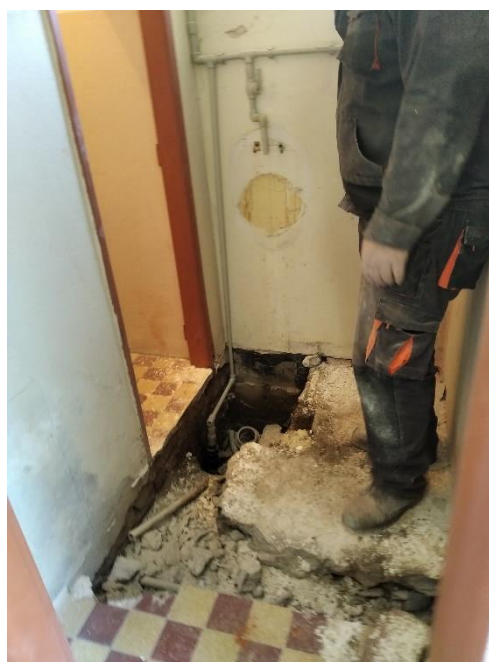
Práce na WC v kulturním domě v Lipovce.
