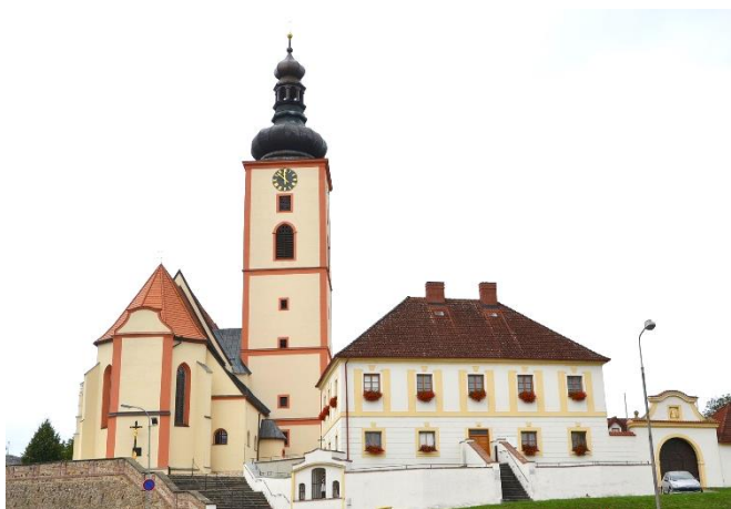
Kostel Povýšení sv. Kříže
